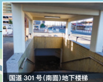
国道 301号(南面)地下楼梯
